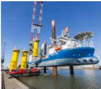
Vole au Vent for Borkum Riffgrund II Wagenborg, Julianahaven
